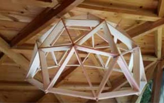
LiSiFa bedeutet: Light- kein Bauteil ist schwerer als 5 kg. Simple - im Grunde besteht die Konstruktion aus zwei Komponenten: dem gelben und dem blauen Holzteil. Fast - der Grundaufbau ist in wenigen Tagen aufgebaut, zunächst genügt
