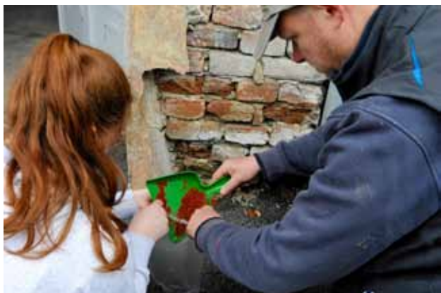
alle: Mauerproben werden entnommen, Vermessungsarbeiten durchgeführt und festgehalten
